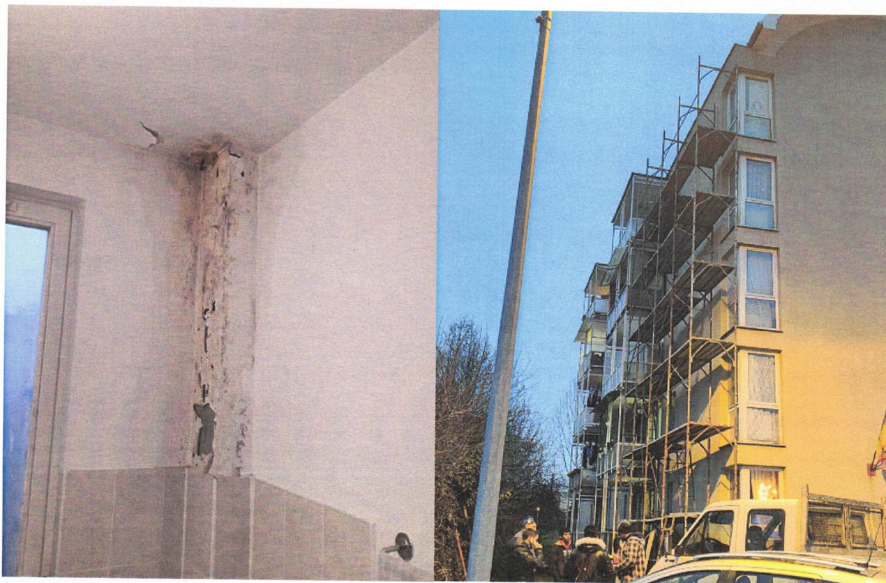
Reparații acoperiș – scurgere apă pluvială – bloc ANL -Plaiului - str. Bld. 1 Dec 1918, nr. 40-42
