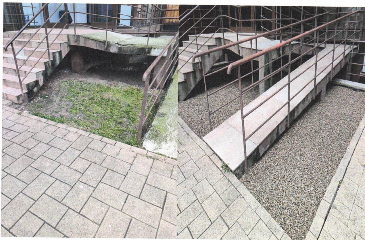
Refacere/ reparație pavaj și rampa pentru persoane cu dizabilitate Bld. Pandurilor 44-46
