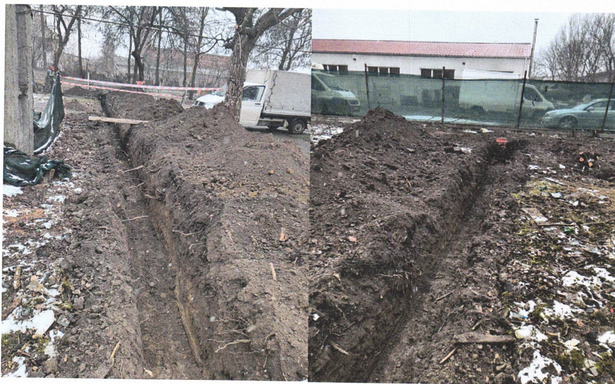
Refacere branșament canalizare locuințe sociale str. Băneasa nr. 8 - racordare la branșamentul stradal
